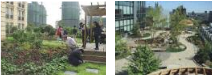
FIGURA 64: Exemplo de coberturas verdes intensivas.
