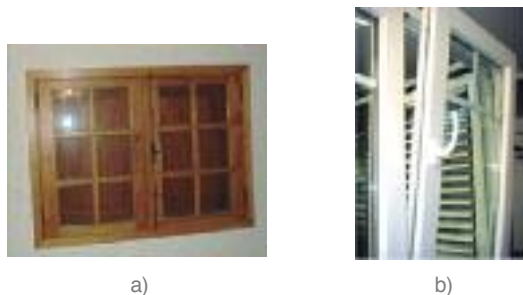
FIGURA 16: Vãos envidraçados: a) giratório, em madeira; b) oscilo-batente, em PVC.
