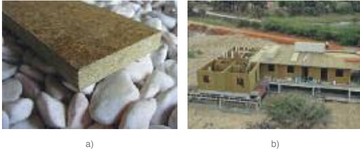
FIGURA 76: Painéis de resíduos da indústria automóvel: a) painel; b) exemplo da sua aplicação na construção de habitações.
