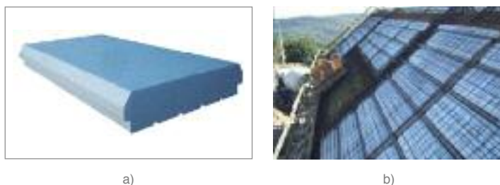
FIGURA 59: Abobadilhas em EPS: a) figura esquemática; b) aplicação em obra.
