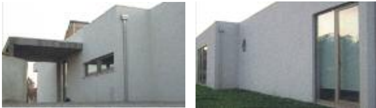
FIGURA 84: Aspecto final de construção executada em módulos de aço galvanizado.
