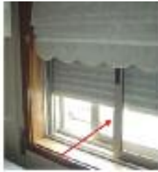
FIGURA 18: Exemplo de uma janela dupla
