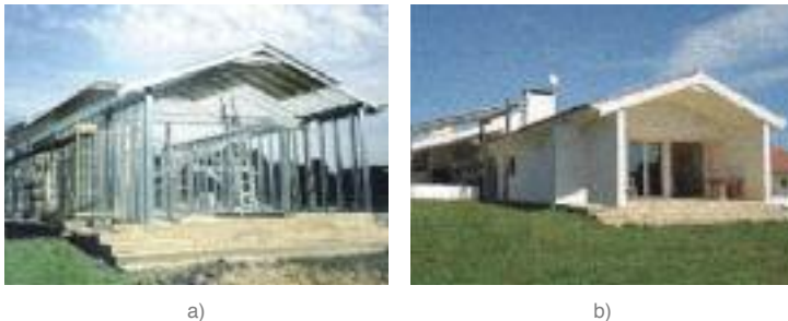
FIGURA 74: Construção com perfis de aço leve: a) montagem dos perfis; b) moradia com acabamentos.
