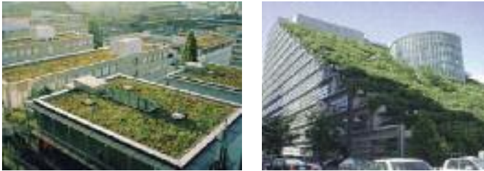
FIGURA 63: Exemplo de coberturas verdes extensivas.
