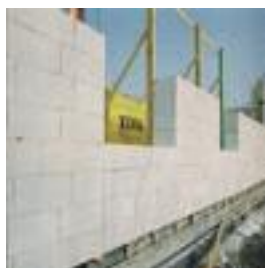
FIGURA 67: Exemplo da aplicação de blocos de betão celular autoclavado na construção de paredes.
