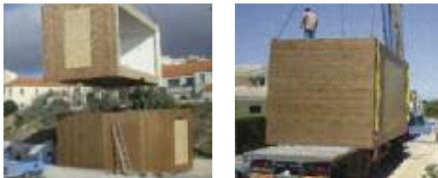
FIGURA 79: Transporte de uma construção modular em madeira.
