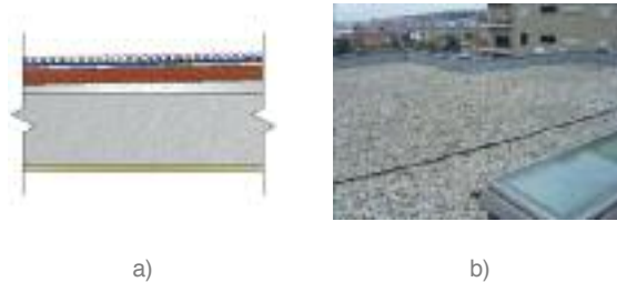
FIGURA 7: Cobertura horizontal com revestimento em godô: a) desenho esquemático; b) situação real.
