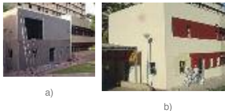
FIGURA 87: Imagens da aplicação do sistema na obra de ampliação do Hospital Distrital de Faro: a) Fase de montagem; b) Fase de acabamentos.
