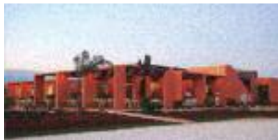
FIGURA 82: Exemplo de construção de uma unidade hoteleira em módulos de betão reforçado com fibras.
