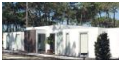
FIGURA 81: Exemplo de construção de uma habitação em módulos de betão reforçado com fibras.
