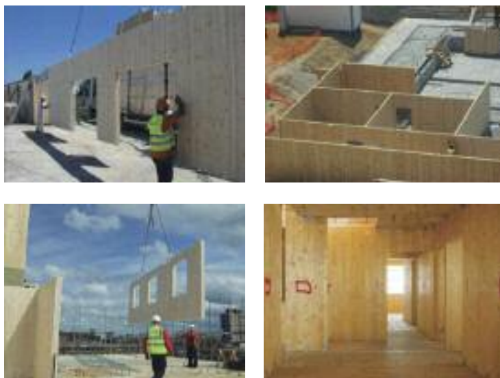
FIGURA 72: Exemplo da montagem de painéis de X-LAM.
