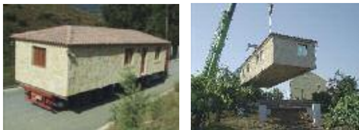
FIGURA 85: Transporte e montagem de uma construção modular em granito.
