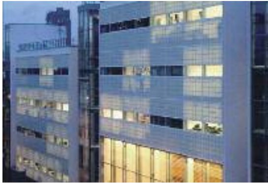
FIGURA 35: Exemplo da aplicação de painéis translúcidos de aerogel em edifícios.
