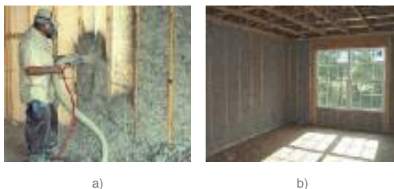
FIGURA 38: Pasta celulósica: a) projecção; b) aspecto final de paredes com pasta celulósica projectada.
